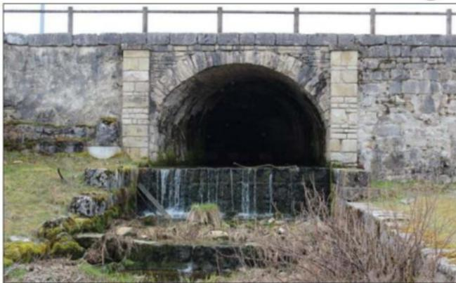
**« La digue sous le moulin est en mauvais état et, lors des fortes pluies, les joints ne semblent plus faire l'effet escompté », selon le constat des élus. Photo ER**
