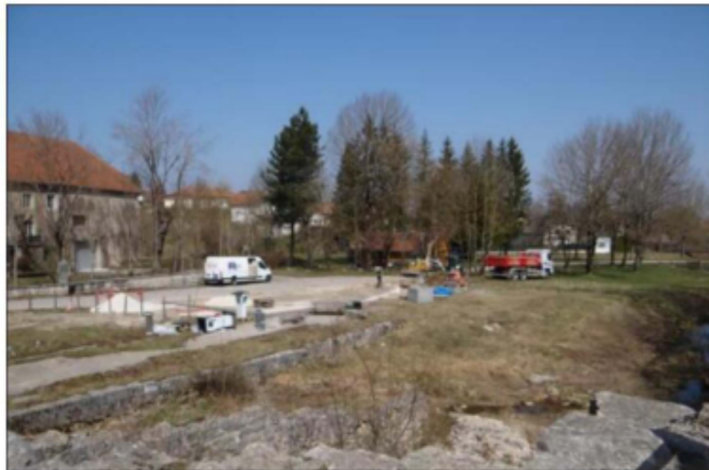
Les travaux ont commencé pour la création de l'aire de camping-cars. Photo ER
