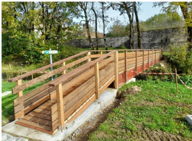
Par ailleurs, la réfection de la passerelle des remparts a été effectuée avec des poutres métalliques, remplaçant les troncs précédemment utilisés. Les coûts associés à ce projet s'élèvent à 12 735 € HT pour le terrassement et 12 275 € HT pour les matériaux.
