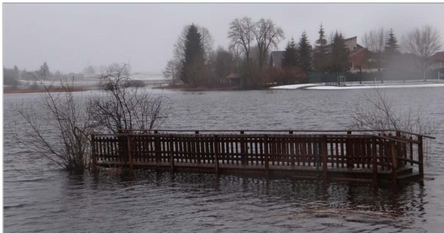
Le Drugeon s'était étalé de tout son long, un pont était même à l'eau, mais heureusement la décrue est amorcée.
