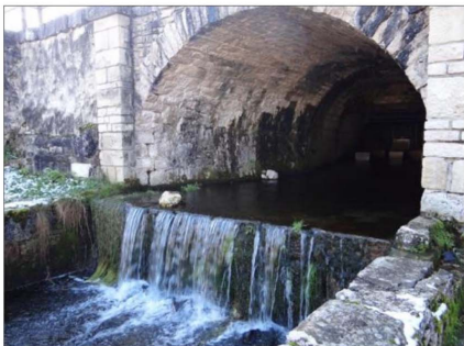
Sous la digue. Photo ER
