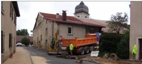
Un chantier pour améliorer la circulation des piétons. Photo ER
