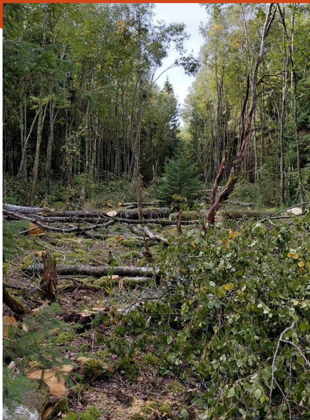
Figure 4 : Chantier de déboisement
