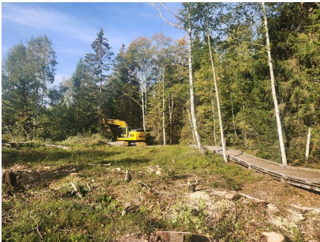
Figure 2 : Travaux de déboisement impactant l'accessibilité au sentier pour les prochains mois.
